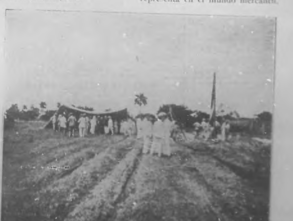
LA COMPAÑIA QUIMICO-INDUSTRIAL DE CUBA.—Otro aspecto de los terrenos el día de la colocación de la primera piedra de los futuros edificios.
